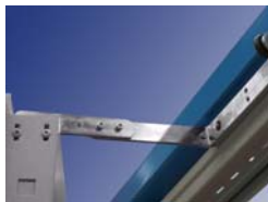
Selector de cierre puertas doble hoja Closure selector for two leaf doors. Sélecteur de fermeture pour portes double-ventaux
